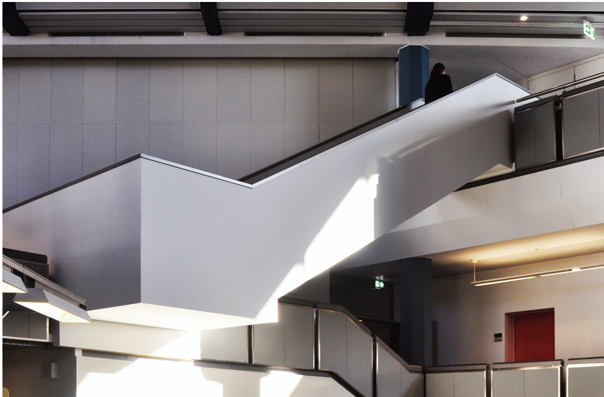
Es geht voran in Sachen Bau: die neue Treppe zum BibTop
